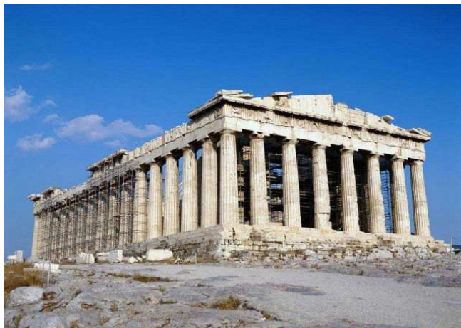
Şəkil 7. Parfenon məbədinə memar Balanos tərəfindən anastiloz üsulu ilə aparılmış fraqmentar bərpa işləri. Yunanıstan
